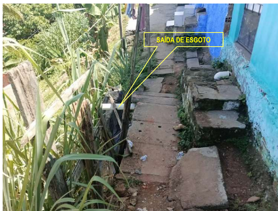
Figura 5.6. - Foto da via de acesso a montante do talude, observa-se a saída de tubulações de esgoto que incidem na face do talude.
