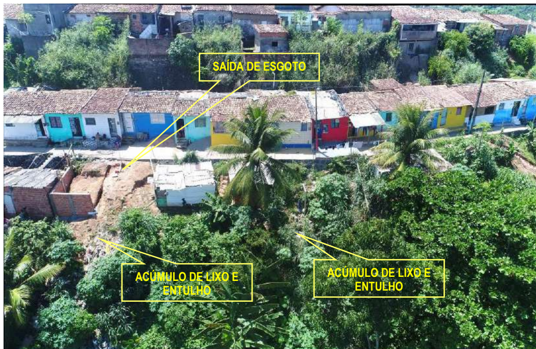
Figura 5.1.- Vista aérea frontal (lado esquerdo) do talude a ser estabilizado, observa-se o acúmulo de lixo, entulho e saídas de esgoto presentes no talude.
